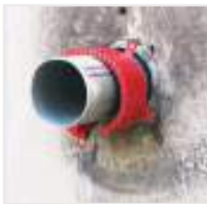
۱- سوراخ‌کاری محل عبور لوله به محیط دیگر را انجام دهید.
