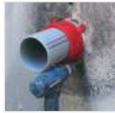
۵- حلقه را از سوراخ‌های تعبیه شده توسط چهار عدد پیچ به دیوار فیکس کنید.
