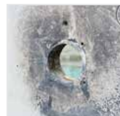
۱- سوراخ‌کاری محل عبور لوله به محیط دیگر را انجام دهید.
