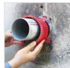
۴- حلقه را بعد از مماس کردن با دیوار دور لوله قرار دهید.
