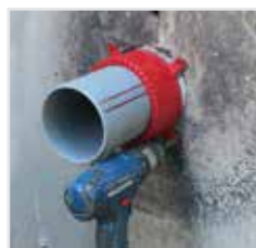
۵- حلقه را از سوراخ‌های تعبیه شده توسط چهار عدد پیچ به دیوار فیکس کنید.
