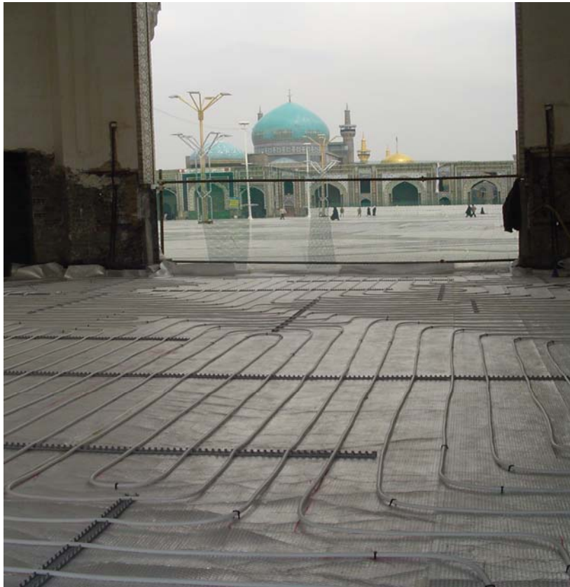
نمونه اجرای سیستم ذوب برف
