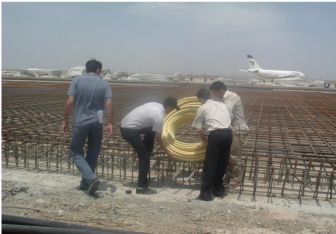
نمونه اجرای سیستم گرمایش کفی در محیط‌های صنعتی
