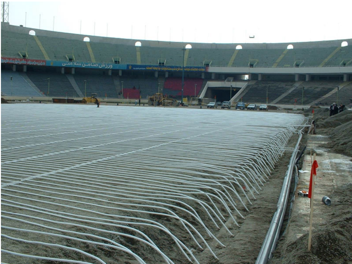
نمونه اجرای سیستم گرمایش کفی در محیط‌های صنعتی
