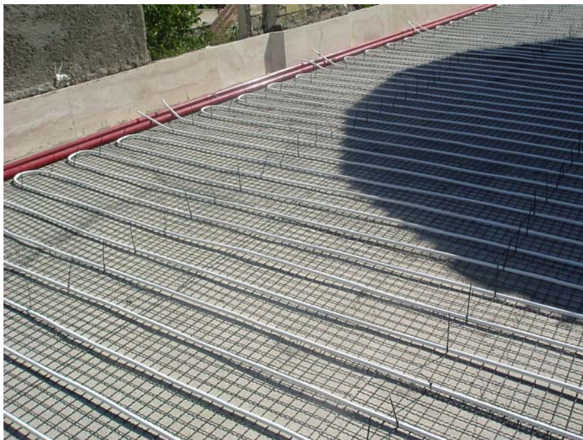
نمونه اجرای سیستم ذوب برف
