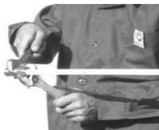
سفت کردن اتصالات مهره ماسوره‌ای
