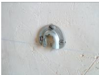
۱- ابتدا صفحه دیواری گرد را روی دیوار با پیچ و رولپلاک محکم نمایید.
