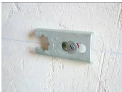
۱- ابتدا صفحه را روی دیوار با پیچ و رولپلاک محکم نمایید.
