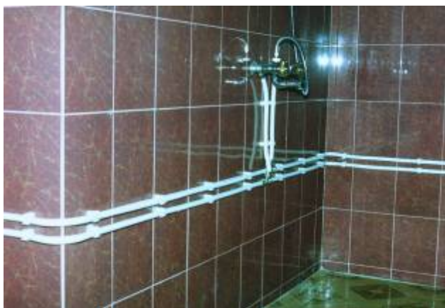
نمونه اجراهای روکار و اتصالات مخصوص آن
