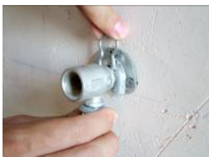
۱- ابتدا صفحه دیواری گرد را روی دیوار با پیچ و رولپلاک محکم نمایید.
