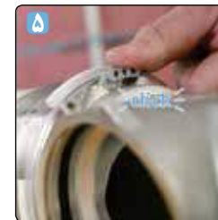
۱ لوله‌ی سوپر پایپ کالیبره شده را وارد رابط پرس کنید.
