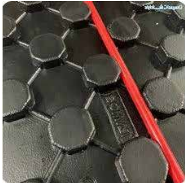
برجستگی‌های عایق شانه تخم‌مرغی مانع پوشش کامل لوله توسط بتن گرمایش کفی می‌شوند.
