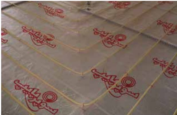
با اجرای ورق حبابدار متالایز سیستم گرمایش کفی از نظر مصرف انرژی کاملاً بهینه خواهد بود.
